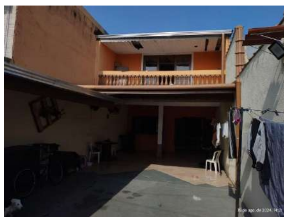
Foto 3 – Vista da fachada interna
