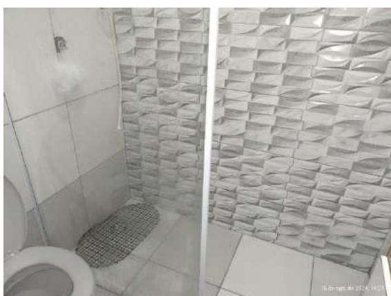
Foto 8 – Vista do banheiro
