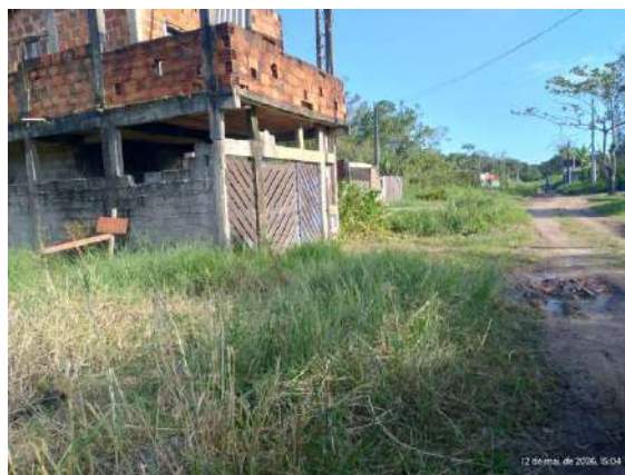
Foto 3 – Vista da calçada sentido centro
