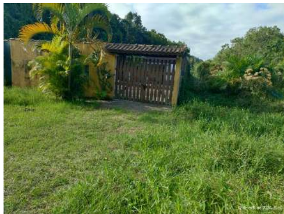
Foto 3 – Vista da esquina da rua do IA
