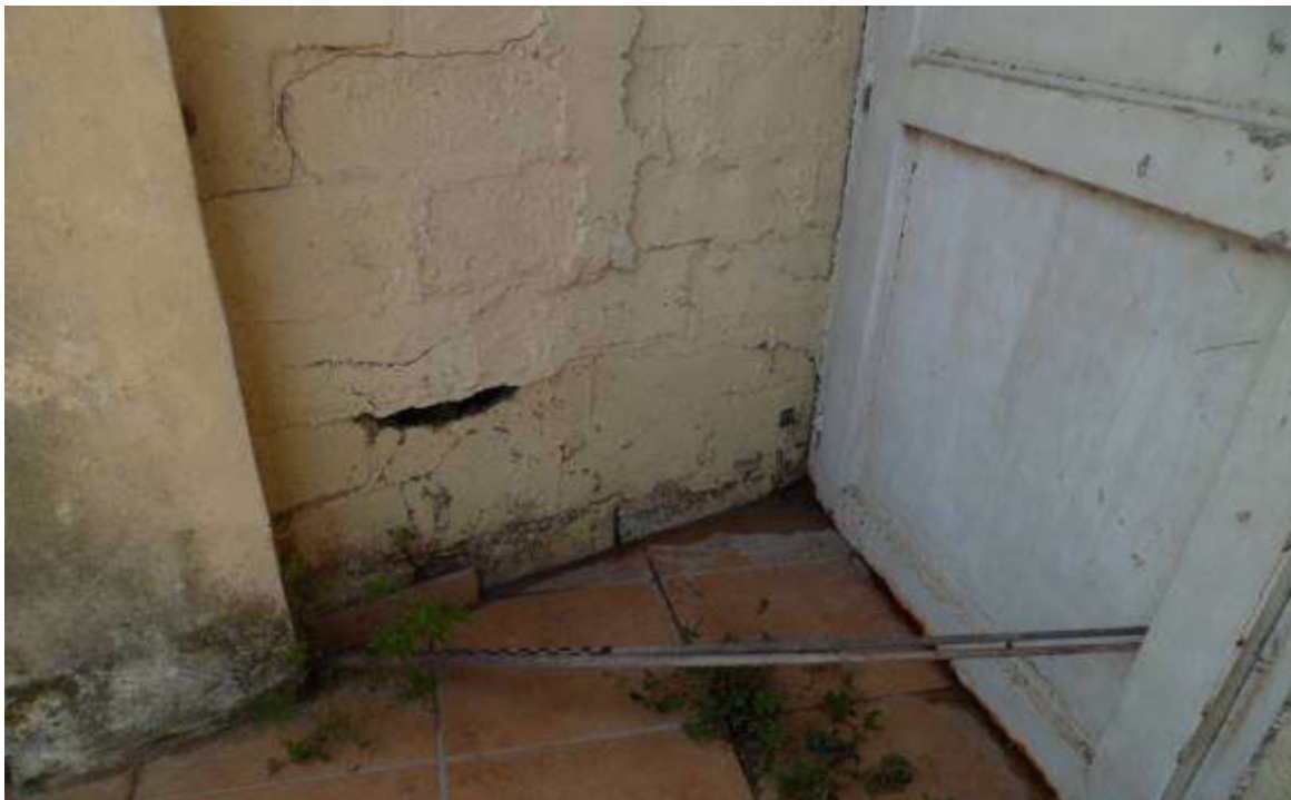
FOTO nº 19 Vista do quintal, com detalhe para as trintas no muro de divisa.
