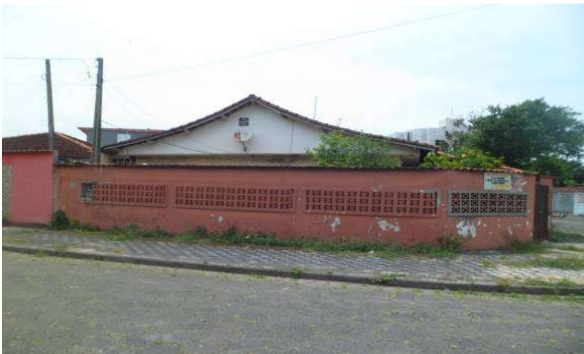
FOTO nº 05 Vista da fachada do imóvel, com testada voltada para a Rua Sorocabana.
