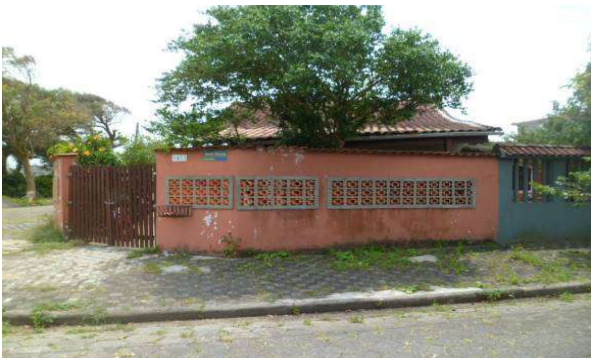
FOTO nº 06 Vista da fachada do imóvel, com testada voltada para a Rua Santa Cecília.
