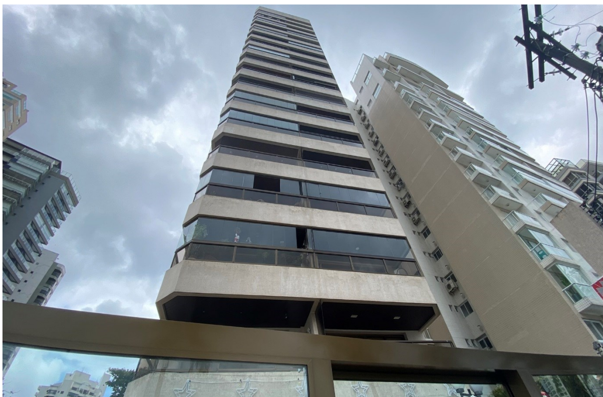
FOTO 01 -Vista parcial da fachada frontal do “Condomínio Edifício Manihi”.
