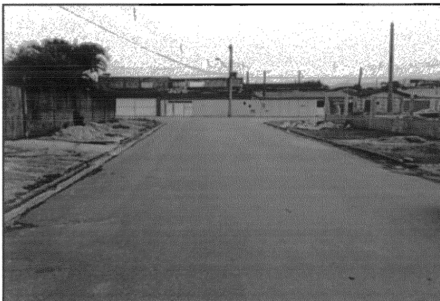
Imagem 1: Vista da Rua Santana (defronte ao imóvel)
