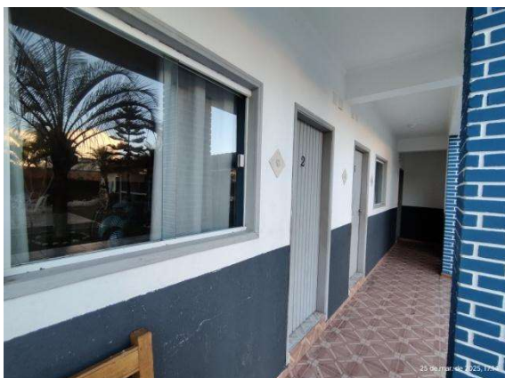
Foto 12 – Vista das fachadas das suítes térreas
