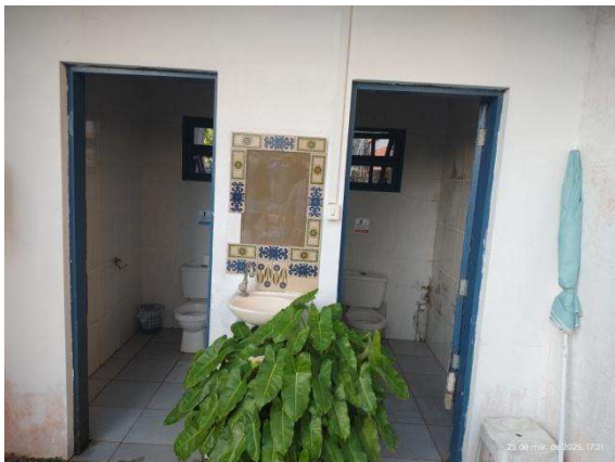
Foto 22 – Vista externa dos lavabos da piscina
