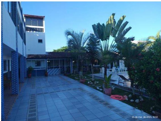
Foto 4 – Vista da entrada pelo estacionamento
