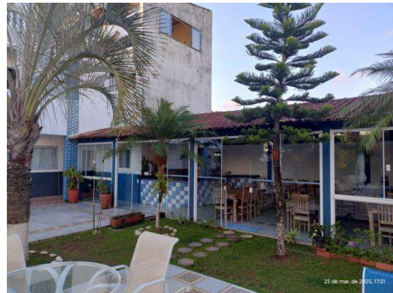
Foto 21 – Vista externa do restaurante
