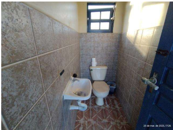
Foto 30 – Lavado do 2º piso
