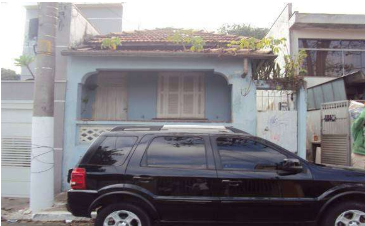
FOTO nº 03 Vista da fachada do imóvel.
