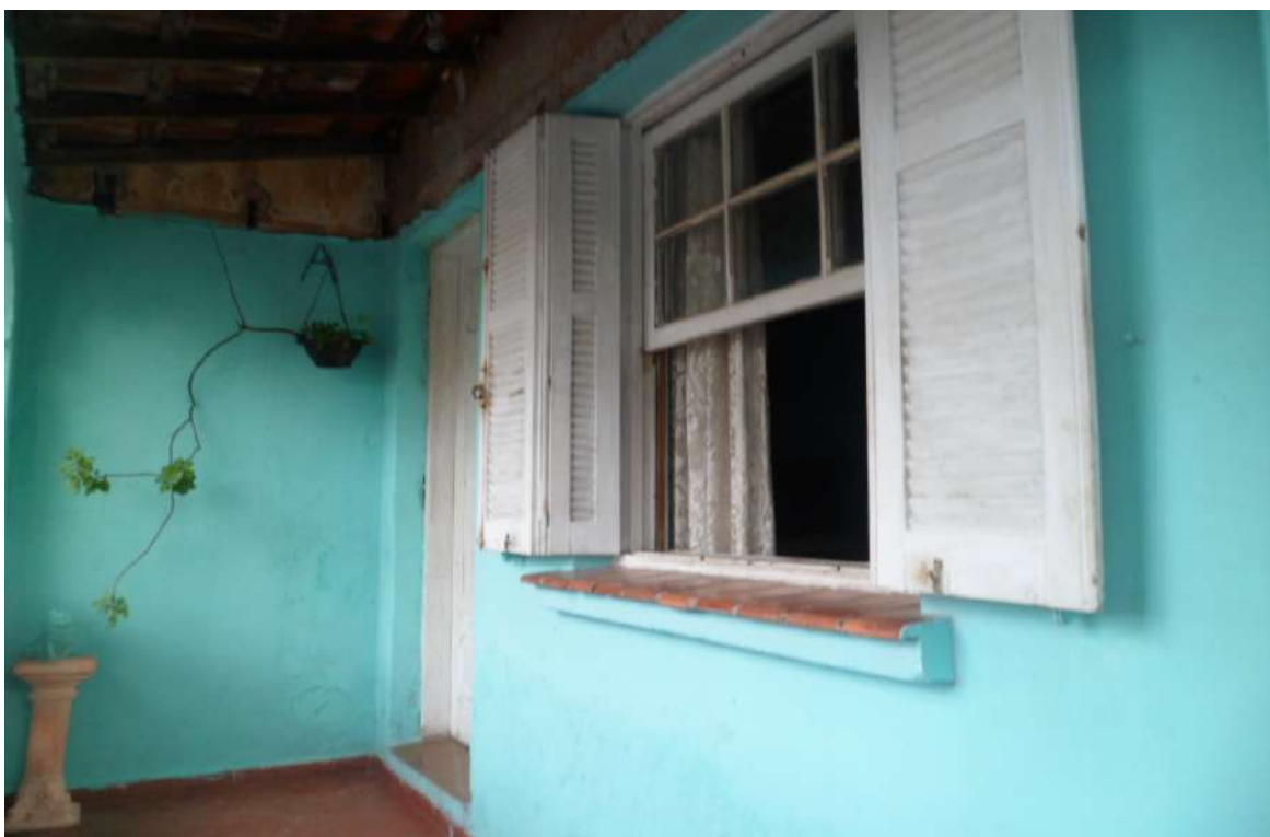
FOTO nº 04 Vista da varanda de acesso ao imóvel.
