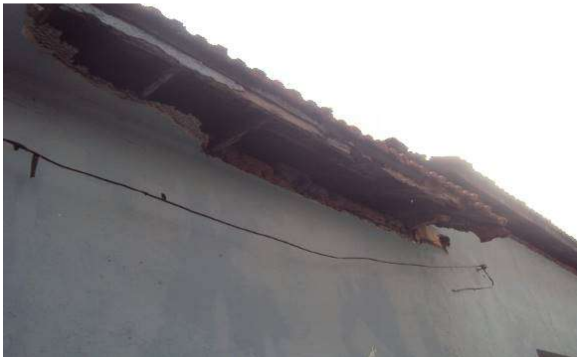
FOTO nº 13 Detalhe da fachada lateral junto ao telhado.
