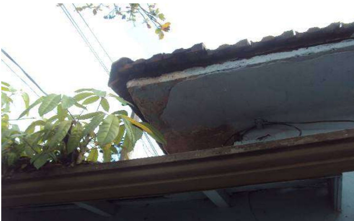
FOTO nº 22 - Outra vista do telhado.
