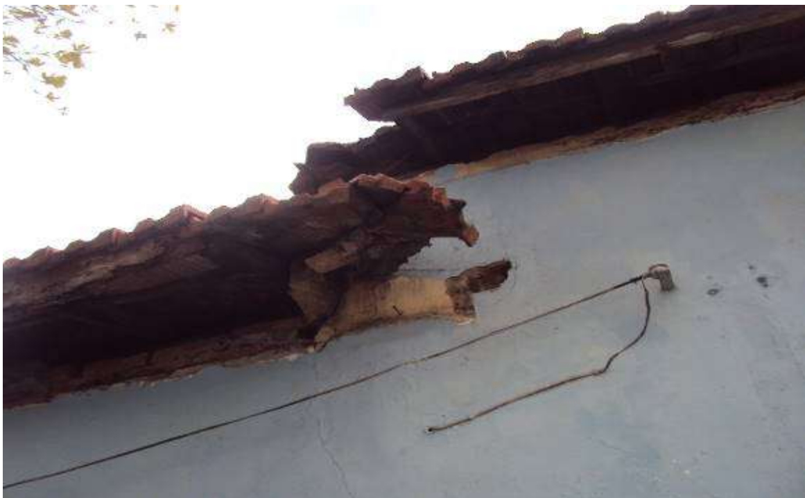
FOTO nº 21 Detalhe para a parede junto ao telhado, com detalhe para seu estado de conservação.
