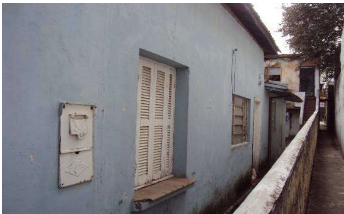
FOTO nº 14 Vista da fachada lateral do imóvel, tomada de outra posição.
