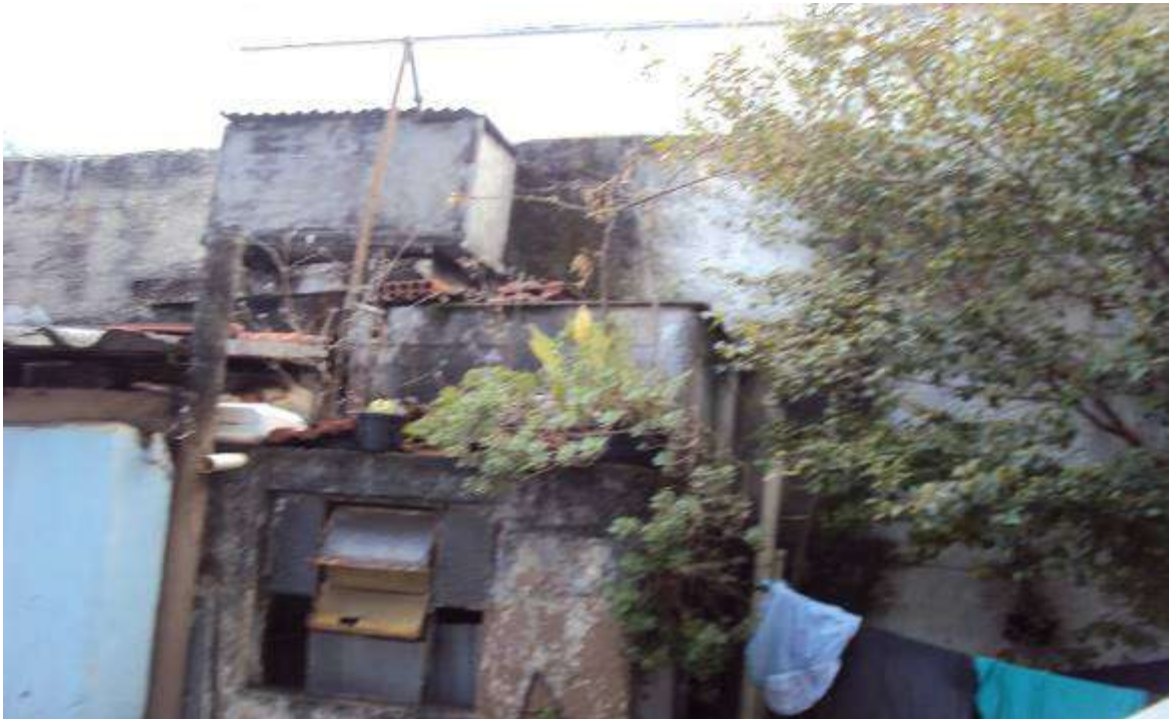
FOTO nº 16 Vista do banheiro na parte dos fundos do terreno.
