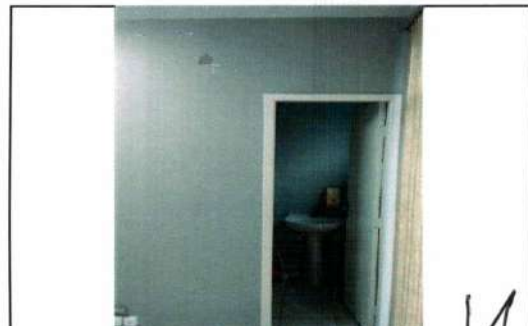
VISTA PARCIAL INTERNA DE UM DOS BANHEIROS
