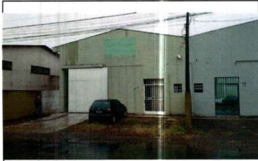
VISTA DA FACHADA DO IMÓVEL EM ESTUDO
